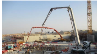
Construction d'un stade au Qatar pour le coupe du Monde
